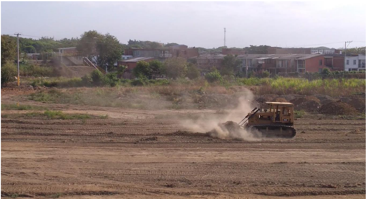
Imagen 13 Video Retroexcavadora (lado izquierdo del Jarillón), 2019.
