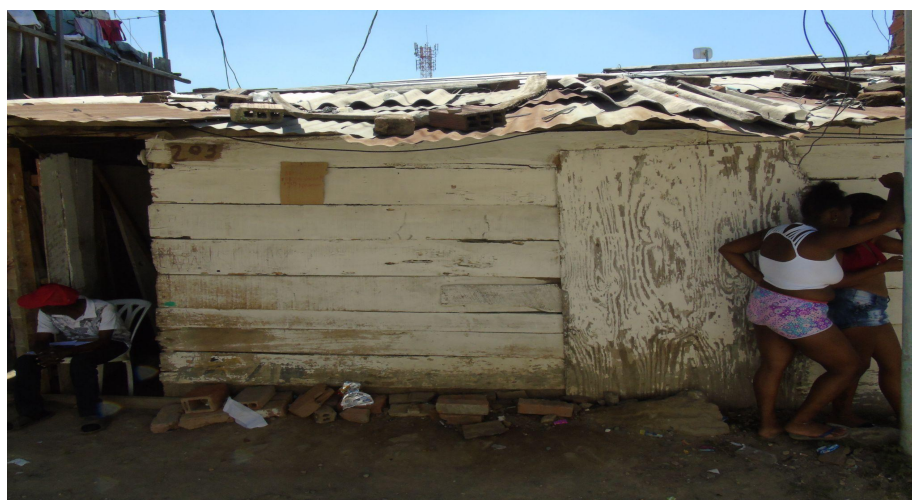
Figura 12: invasión el Valladito; fachada de Rancho o vivienda 2,40cm alto x 3,00 m de ancho; evidencia la medida de lo habitable; 6 de julio 2019; José Manuel Cuesta
