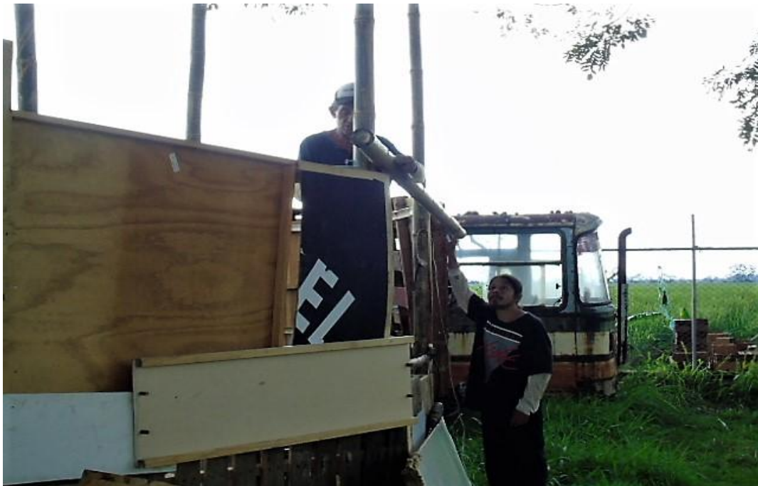
Figura 57: autoconstrucción; soportes techo primer planta y piso de la segunda planta instalación con habitantes de la invasión el Valladito; 10 marzo- 2022 ; fotografía José Cuesta
