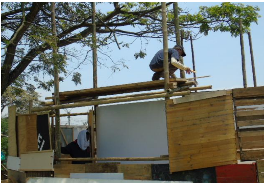
Figura 58: autoconstrucción segunda planta instalación con habitantes de la invasión el Valladito; 12 marzo- 2022; fotografía José Manuel Cuesta
