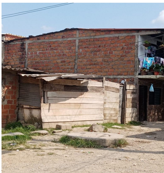
Figura 23; Rancho-vivienda 1; construida con diversos materiales, madera y lamina de zinc fotografía; José Manuel Cuesta; 12-Noviembre-2021 invasión el Valladito.
