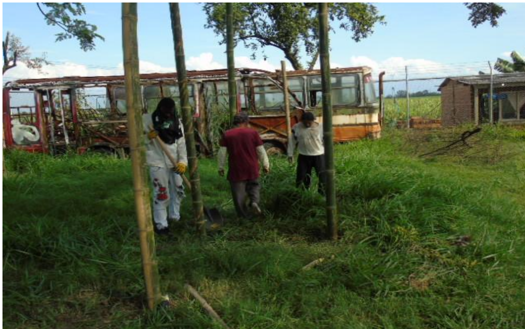
Figura 55: autoconstrucción con habitantes de la invasión el Valladito; enterrando guaduas soportes; 4 marzo- 2022; fotografía José Manuel Cuesta
