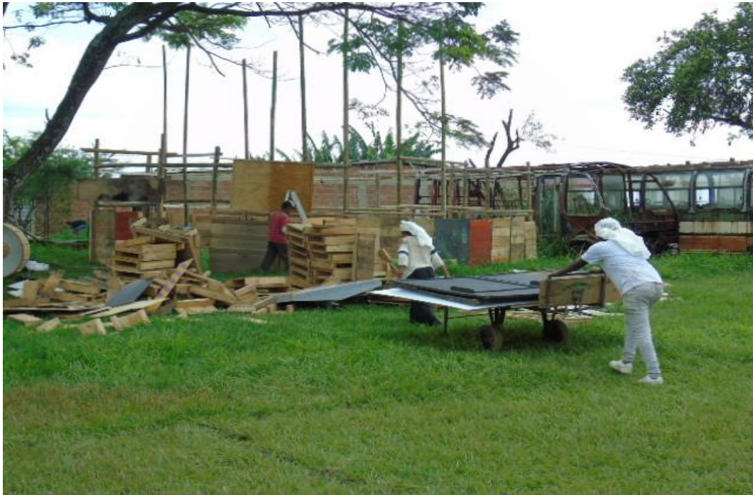
Figura 56: autoconstrucción primer piso instalación con habitantes de la invasión el Valladito; 6 marzo- 2022; fotografía José Manuel Cuesta
