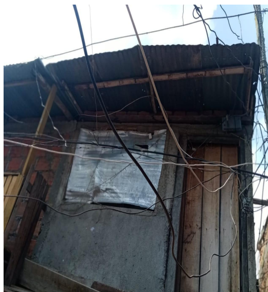
Figura 24; Rancho-vivienda 2; construida con diversos materiales; madera, guadua, ladrillo lámina de zinc; segunda planta; Fotografía: Jose Manuel Cuesta; 12-Noviembre-2021 Invasión Valladito.
