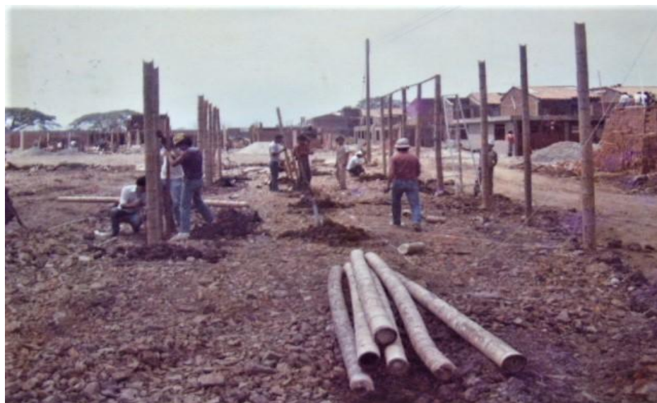
Figura 29: proceso de construcción viviendas en el barrio el Vallado; Año 1984; fuente: Nelson Rodríguez, administrador Polideportivo Vallado.
