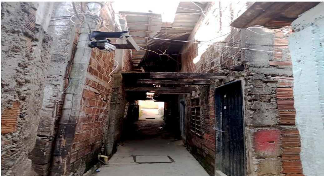
Figura 49: Pasillo invasión Valladolid, muestra la unión de materiales diversa madera guadua, lámina de zinc para crear las viviendas y espacios habitables; Año 2021; fotografía José Manuel Cuesta.
