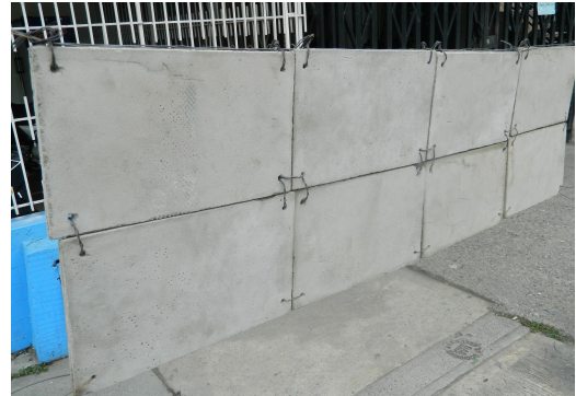
Imagen 10. Intervención pared portátil, barrio los robles cali.
