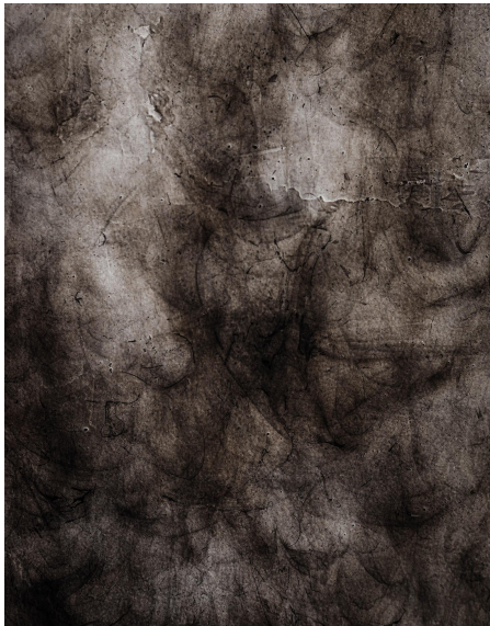
Imagen 6. Detalle de pared intervenida.
