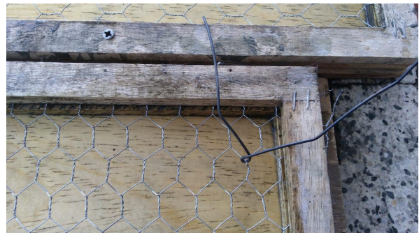
Imagen 28,29. Fotografías del momento cuando se empalman las amarras de alambre en la malla previamente al fundido de concreto. Fuente de elaboración propia.
