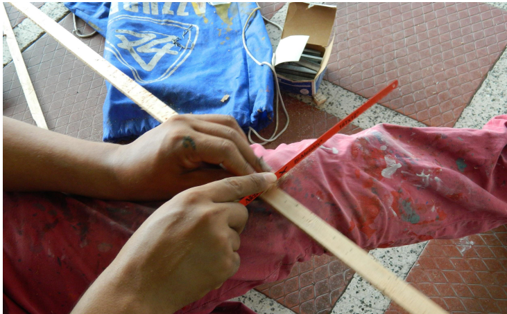
Imagen 23. Fotografía donde se muestra el corte de las piezas para la fabricación de las formaletas. Fuente de elaboración propia.
