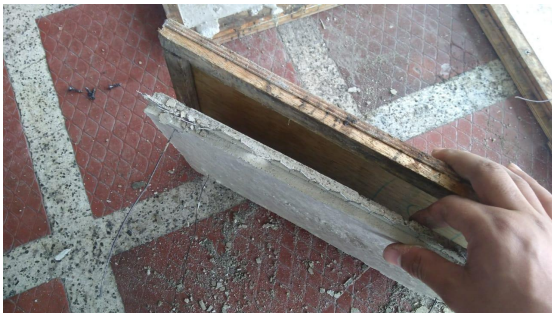
Imagen 31. Fotografía de una placa de concreto seca, saliendo de la formaleta. Fuente de elaboración propia.
