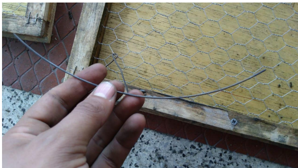
Imagen 28,29. Fotografías del momento cuando se empalman las amarras de alambre en la malla previamente al fundido de concreto. Fuente de elaboración propia.
