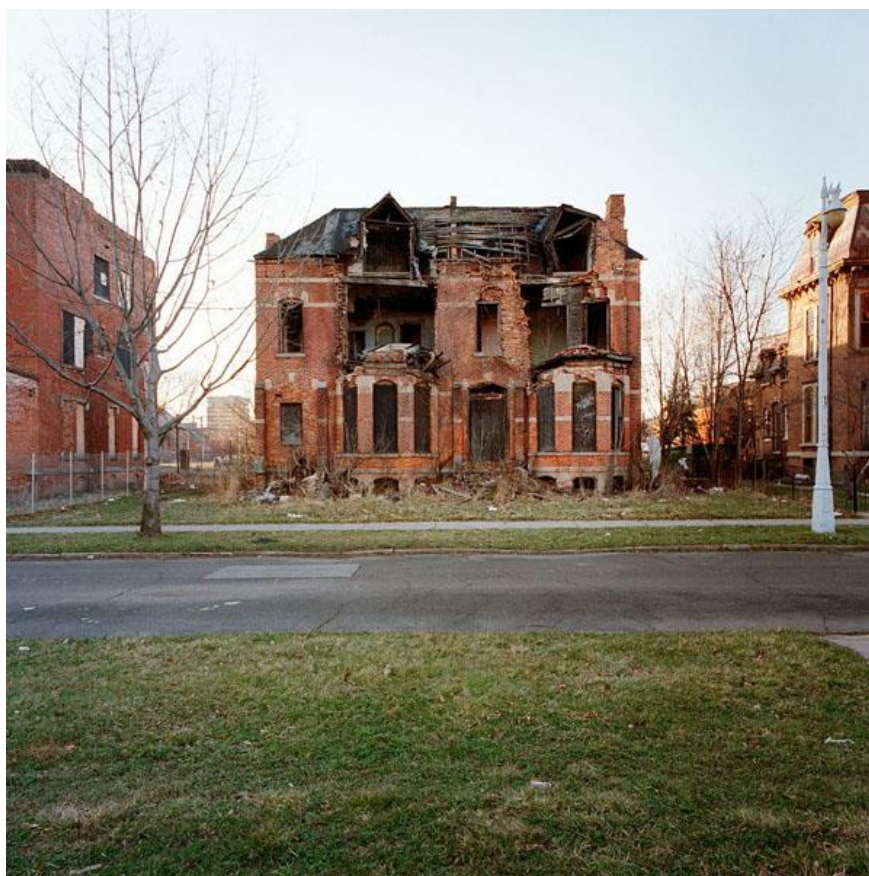
Ilustración 5. Kevin Bauman, fotografía perteneciente a la serie 100 casas abandonadas. Recuperado de: https://www.100abandonedhouses.com/
