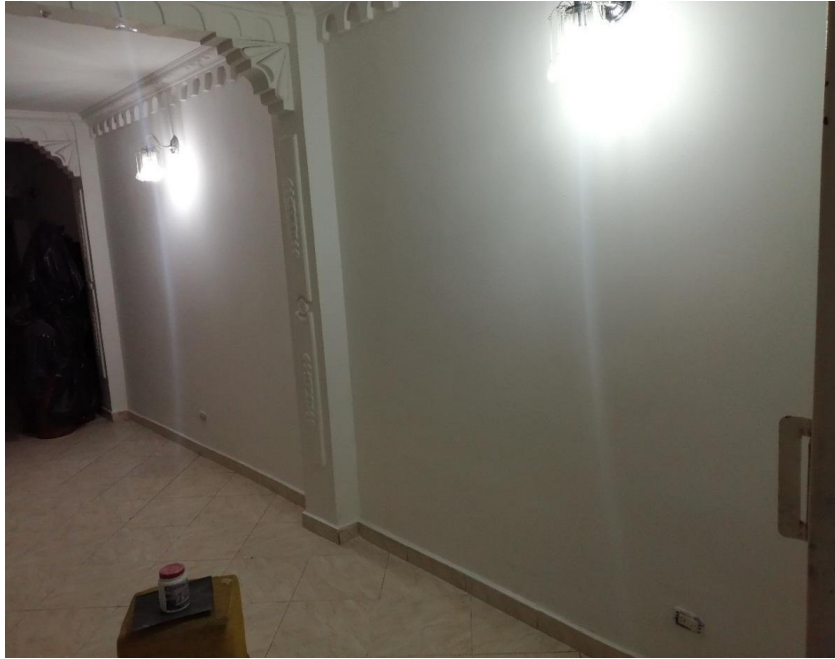
Fotografía no 39 tomada Por Italo Rossi: Proceso secado después de ser intervenida y dejada en óptimas condiciones.
