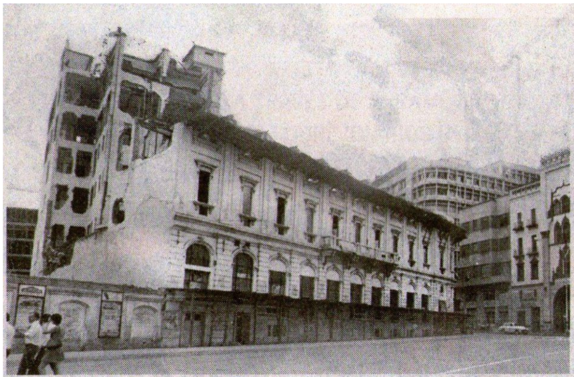
Figura 18: Deterioro y posterior demolición del Hotel Alferez Real en el año 1973.
