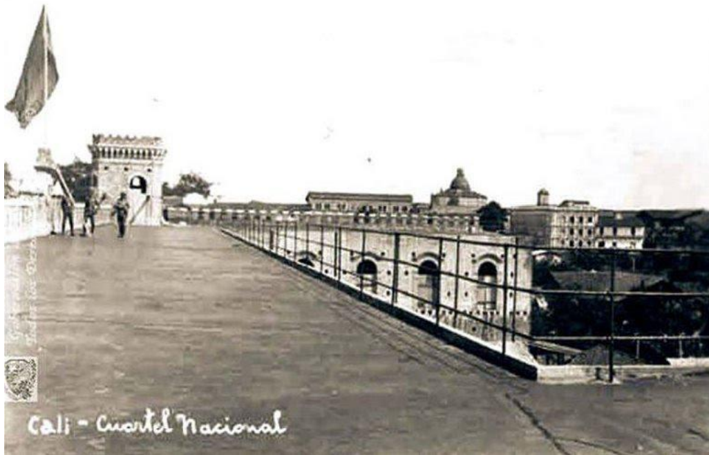
Figura 43: Terraza del Batallón Pichincha, con acceso al último piso de las cuatro torres.
